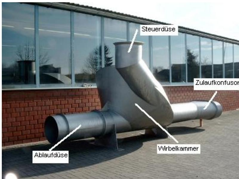
Zur Sicherung eines kontinuierlichen Abflusses aus dem Regenüberlaufbecken Sonnleiten mit einem Bemessungsabfluss von  $Q_b=1.600 \text{ l/s}$ , wurde ein gesteuertes Wirbelventil FluidTriode der Firma UFT-Umwelt- u. Fluidtechnik eingebaut (Typ:WKV K 45 - 4 / DN 600). Dieses Wirbelventil besitzt keine verschleißanfälligen und wartungsbedürftigen beweglichen Teile und arbeitet ohne Hilfsenergie.
