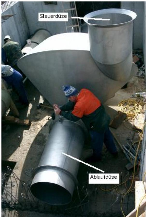
Im Anschluss an die Montage des Zulaufkonfusors wird die Ablaufdüse am Wirbelventil angeflanscht. Auch hier wird das freie Ende später einbetoniert.
