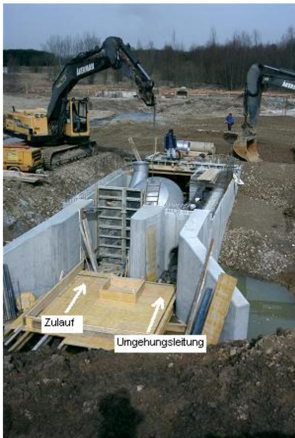
Versetzen des gesteuerten Wirbelventils FluidTriode DN 600. Auf Grund der relativ leichten Bauweise ist das Ventil mit einem Gewicht von ca. 1.000 kg problemlos mittels Bagger zu versetzen.
