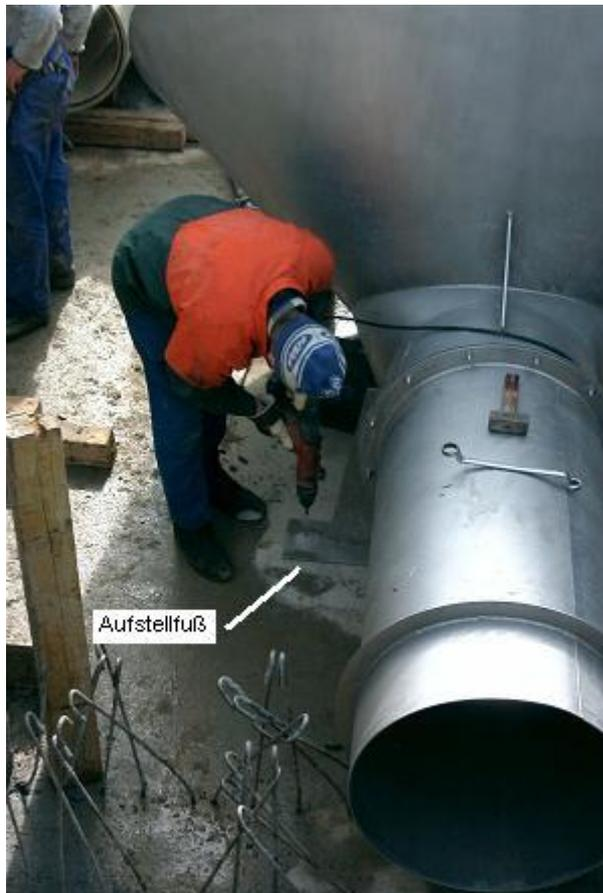
Um eine verschiebesichere Lage des gesteuerten Wirbelventils *FluidTriode* während der Bauphase zu erreichen, wird es anschließend an den Aufstellfüßen fest mit dem Boden verankert.
